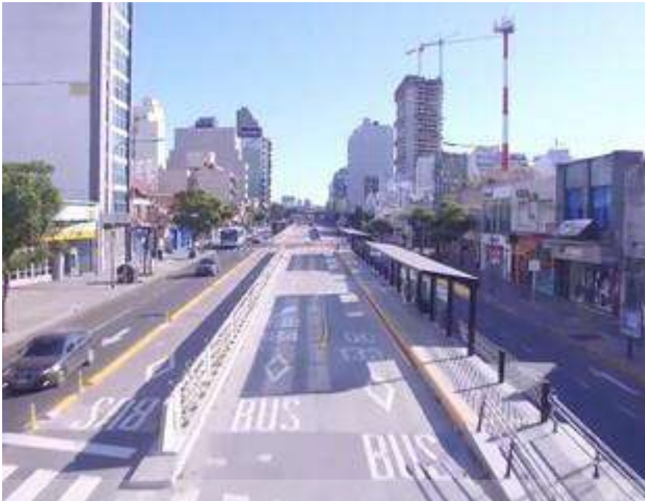
Figura 67. Sistema con estaciones escalonadas y con carril de sobrepaso.
