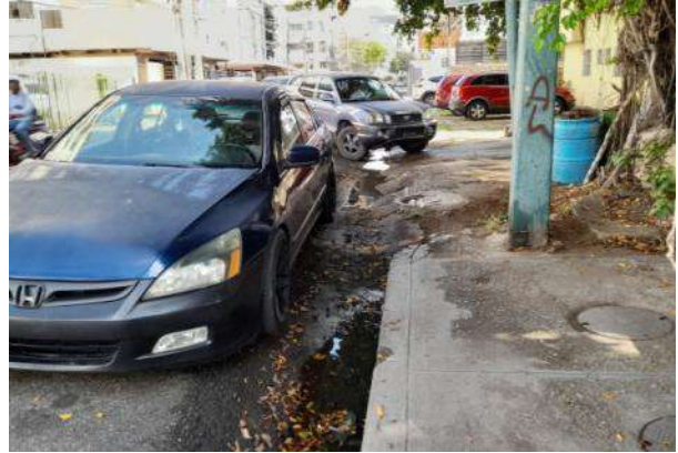
Infraestructura en mal estado
