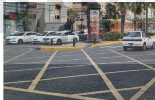
Líneas antibloqueo en intersecciones.
