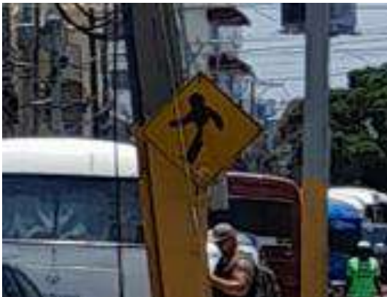
Señal vertical despintada
