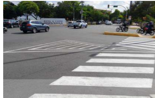
Canalización de la vía.
