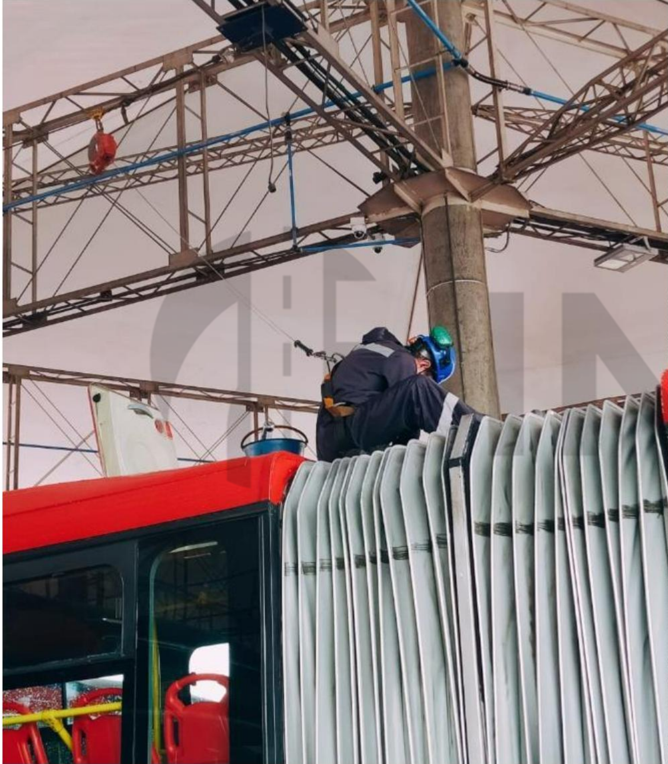
Trabajo seguro en alturas
