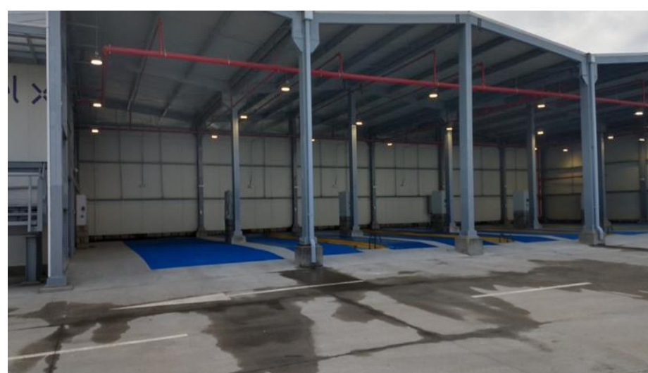
Áreas de mantenimiento preventivo y correctivo con materiales termo acústicos
