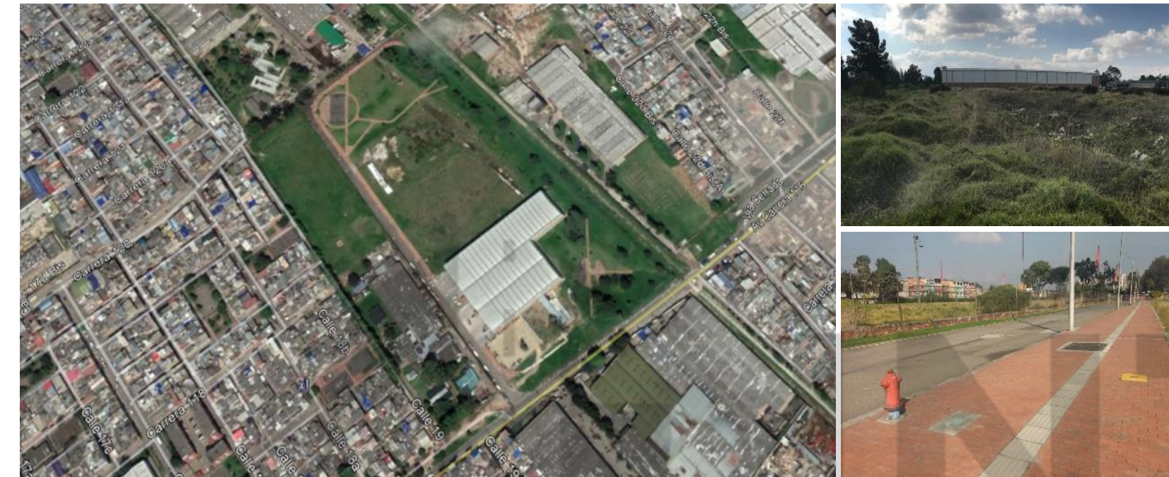
Zona industrial con mezcla de usos residenciales, comercio y servicios
